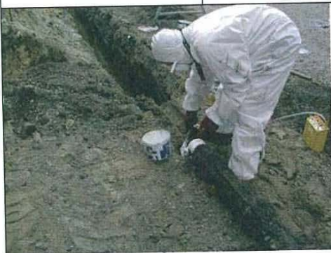
Afwerken kopse kant op breukvlak van een asbestcement waterleidingbuis conform de Werkwijzer van Vewin/Kiwa
